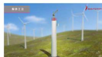
タワークレーン工法
